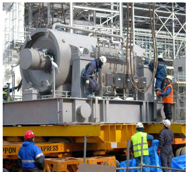
60MB6I LNG mixed refrigerant compressor.
